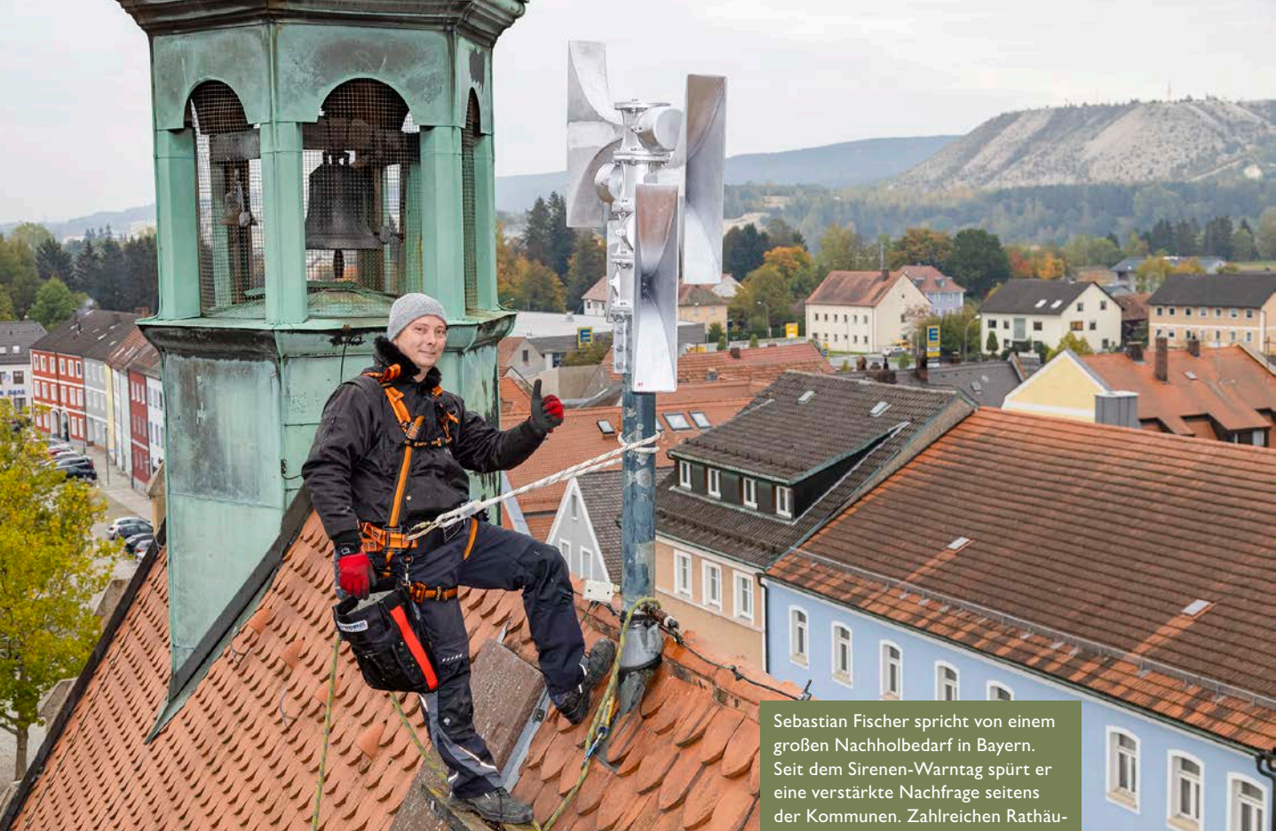
Foto: Sirenbau Fischer
