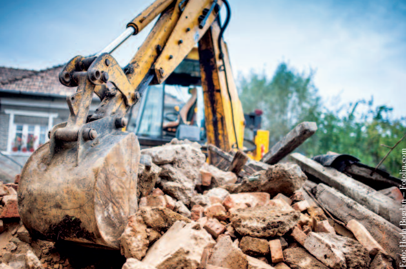
Bauschutt wird in der Regel zerkleinert und wiederverwertet. Leitungen und Rohre und Dämmstoffe enthalten weitere Schätze.
